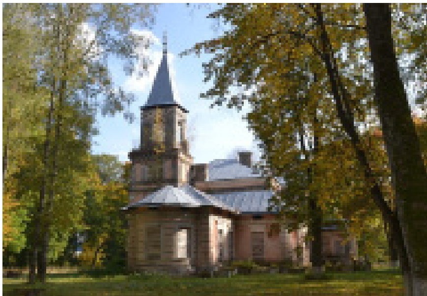
Pałac coraz bardziej niszczeje...
