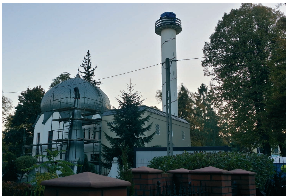
Gdański meczet otoczony rusztowaniami i ze zdemontowaną wieżyczką minaretu.
