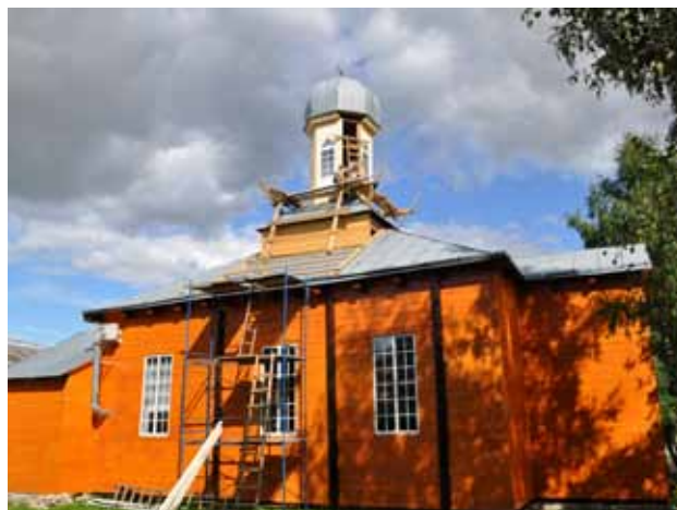
Nowogródzki meczet w trakcie remontu.
